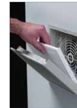
Замена фильтрующего материала
